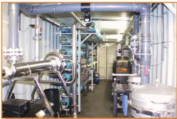
Станция орошения морской воды на греческом острове Итака, проток воды 800 м<sup>3</sup>/день
