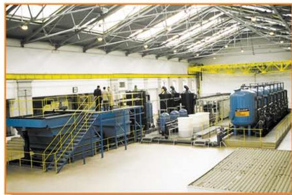
Водопроводная станция в польской шахте чёрного угля Wujek, проток воды 3000 м<sup>3</sup>/день
