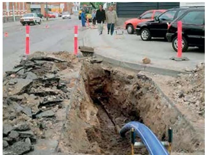
Существуют различные типы труб из полиэтилена, доступные на рынке. Там, где нет дополнительных требований к установке и прочности, применяются традиционные трубопроводы типов 1 и 2 без дополнительной съемной защитной ПП оболочки.
